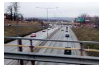
Från Ekhagens trafikplats till A6 trafikplats byggs ett nytt körfält.
